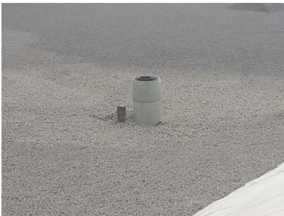
Puisard permettant de recueillir les effluents situé au point bas de l'alvéole
